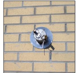
2. Conecte un tubo al muro exterior y, dependiendo del diámetro del tanque y la distancia entre el tanque y el muro, determine la longitud de tubo que necesitará del codo de 2" en la parte superior del tubo de evacuación al muro.
