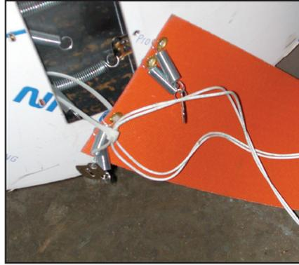
5. Usando pinzas de punta delgada, quite los 4 resortes de las pestañas de soldeo en el tanque para liberar el calefactor. Tenga en cuenta que debe hacer esto en cada extremo para permitir la remoción del calefactor.
