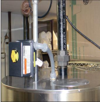
**1.** Conecte un tubo de 2" al tubo de evacuación ubicado en la parte central del tanque para empezar a conectar en el techo.
