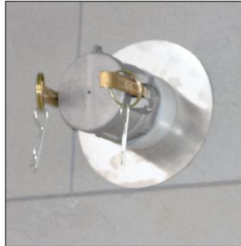
**5.** Haga el orificio a través del muro exterior, e instale el tubo, los conectores y la abrazadera para tubo para completar el conjunto de puerto de recopilación.
