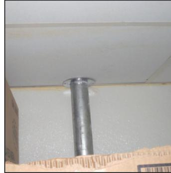
**3.** Baje el tubo del techo. Saque el tubo de 2" del techo a la altura deseada del puerto de recopilación.
