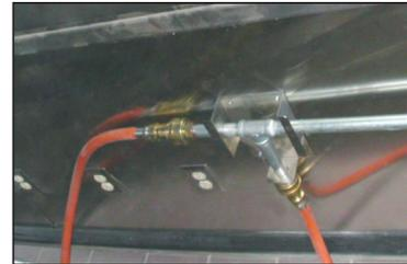
La figura muestra la válvula de retención que se conecta a la salida de aceite usado de la freidora
