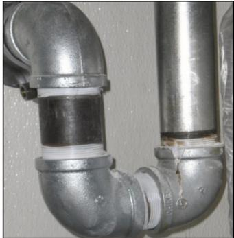
**4.** Con los codos de 2" y los nipples cortos de 2", construya una trampa en "P" para recolectar todo el aceite usado y para eliminar el derrame de aceite cuando quita la tapa desde el exterior del edificio.
