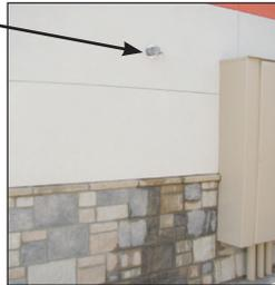
4. Haga el orificio a través del muro exterior, e instale el tubo, los conectores y la abrazadera para tubo para completar el conjunto de puerto de recopilación.
